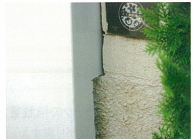
▲段差部分をカットして施工
